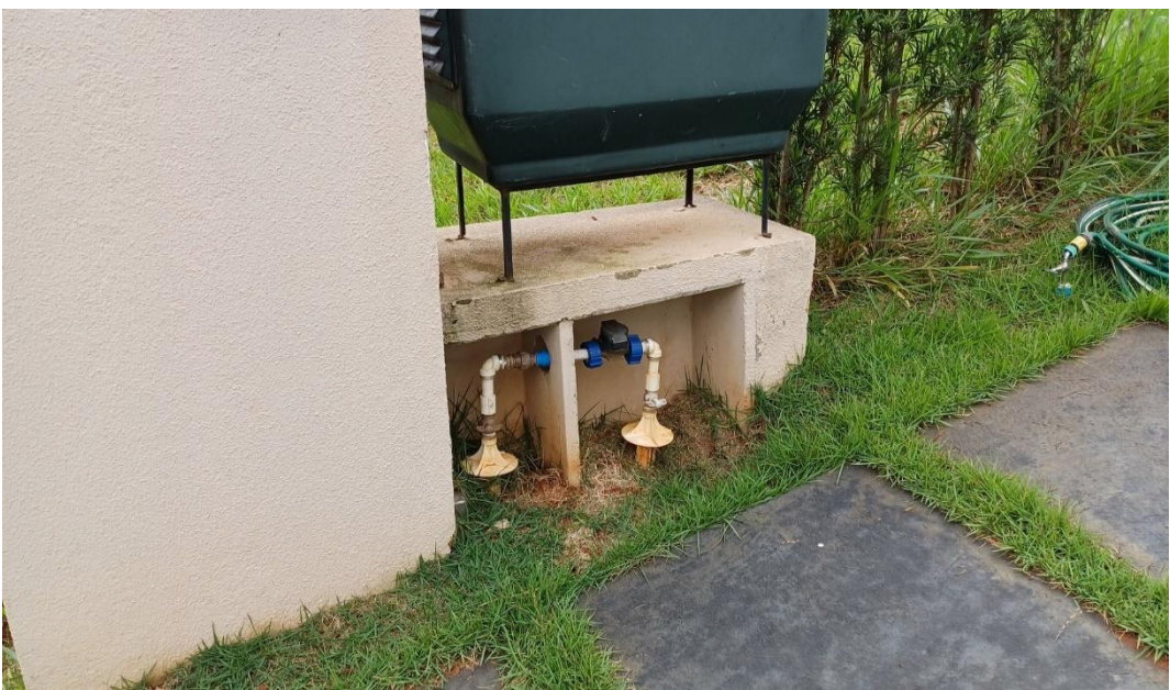
Descrição: VISTA PARCIAL INTERNA DO IMÓVEL
