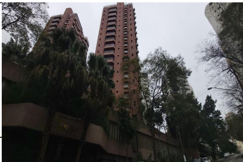
Foto da Fachada do Imóvel
