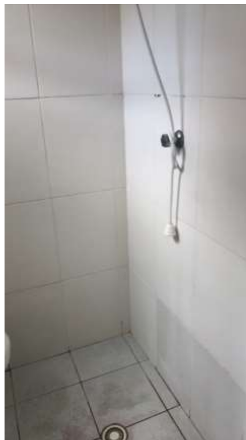
Banheiro de serviços - vista 2
