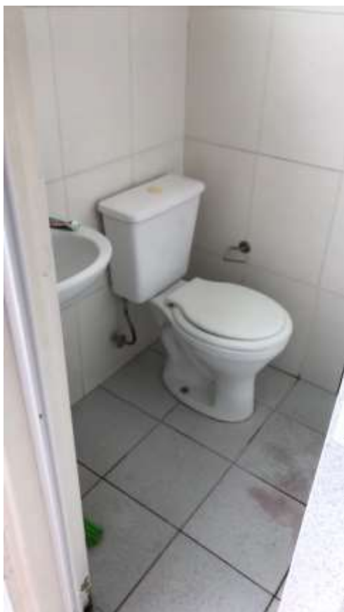
Banheiro de serviços - vista 1
