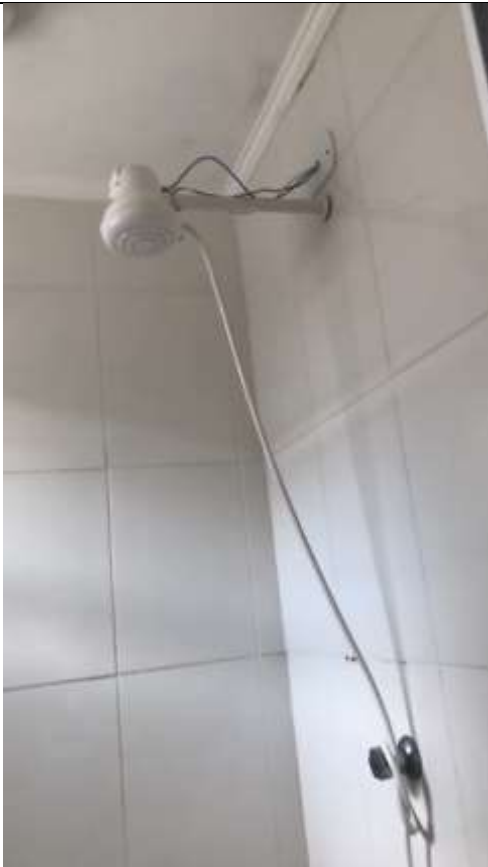
Banheiro de serviços - vista 3
