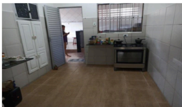
Descrição: VISTA PARCIAL INTERNA DO IMÓVEL
