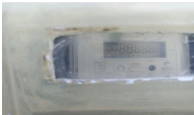
Descrição: VISTA PARCIAL INTERNA DO IMÓVEL
