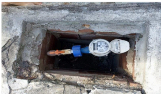
Descrição: VISTA PARCIAL INTERNA DO IMÓVEL
