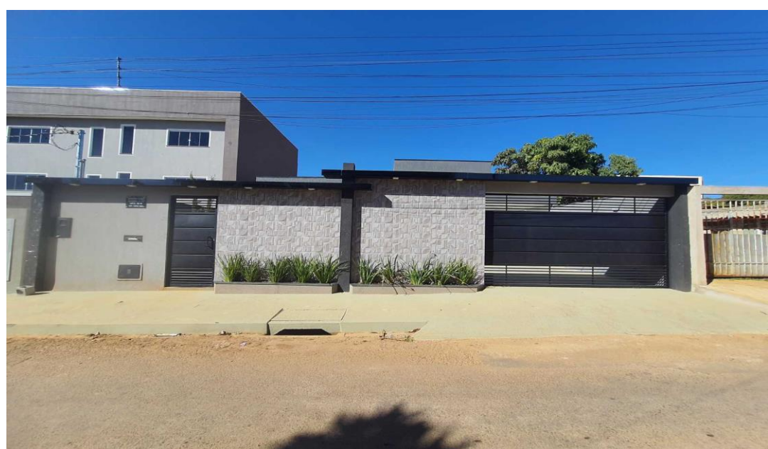
FOTO DA FRENTE DO IMÓVEL
