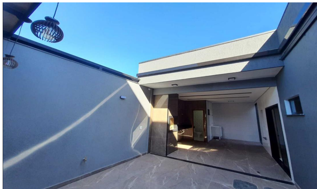
Descrição: VISTA PARCIAL INTERNA DO IMÓVEL
