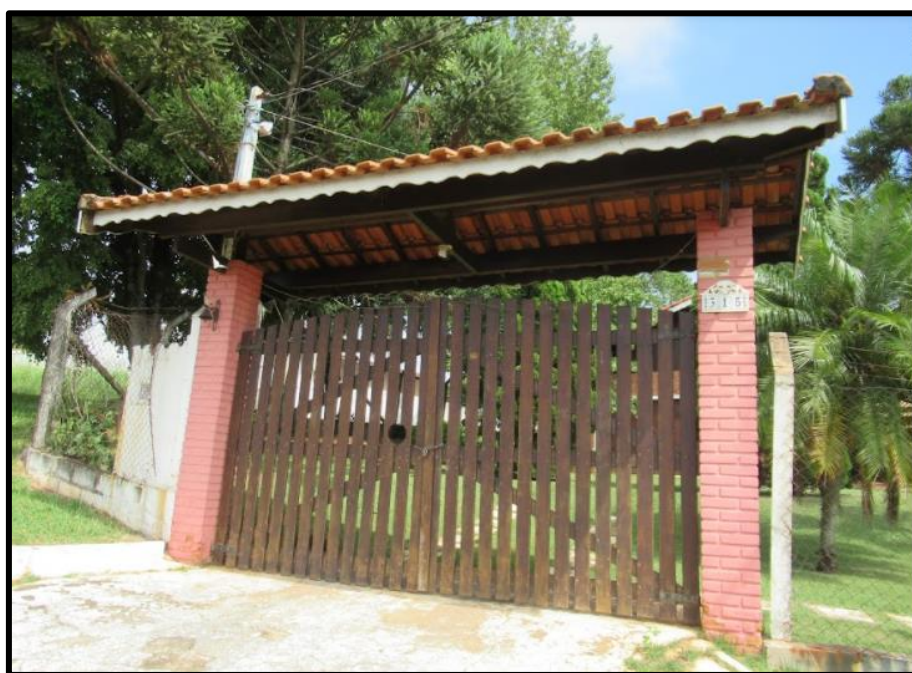
Foto 14: Imóvel avaliando - Rua José Haddad, nº 315
