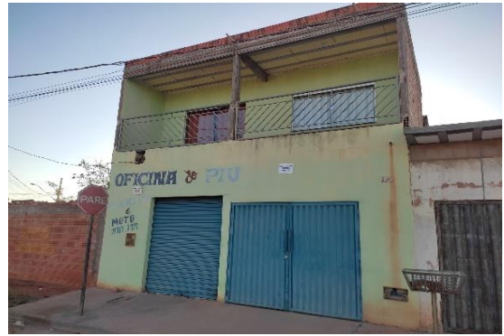
Fachada do avaliando
