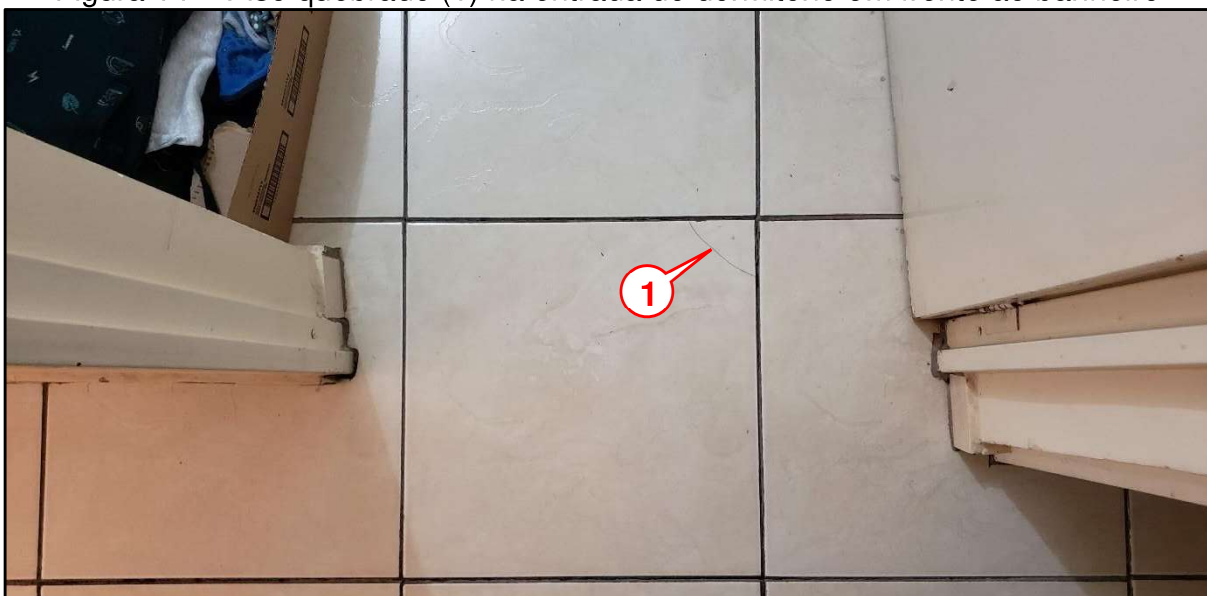
Figura 14 – Piso quebrado (1) na entrada do dormitório em frente ao banheiro
