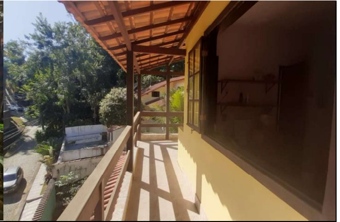
Varanda 3º pavimento
