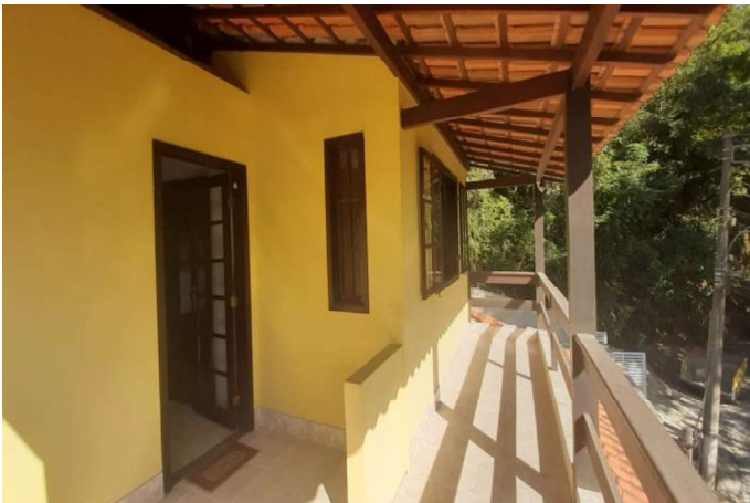
Varanda 3º pavimento
