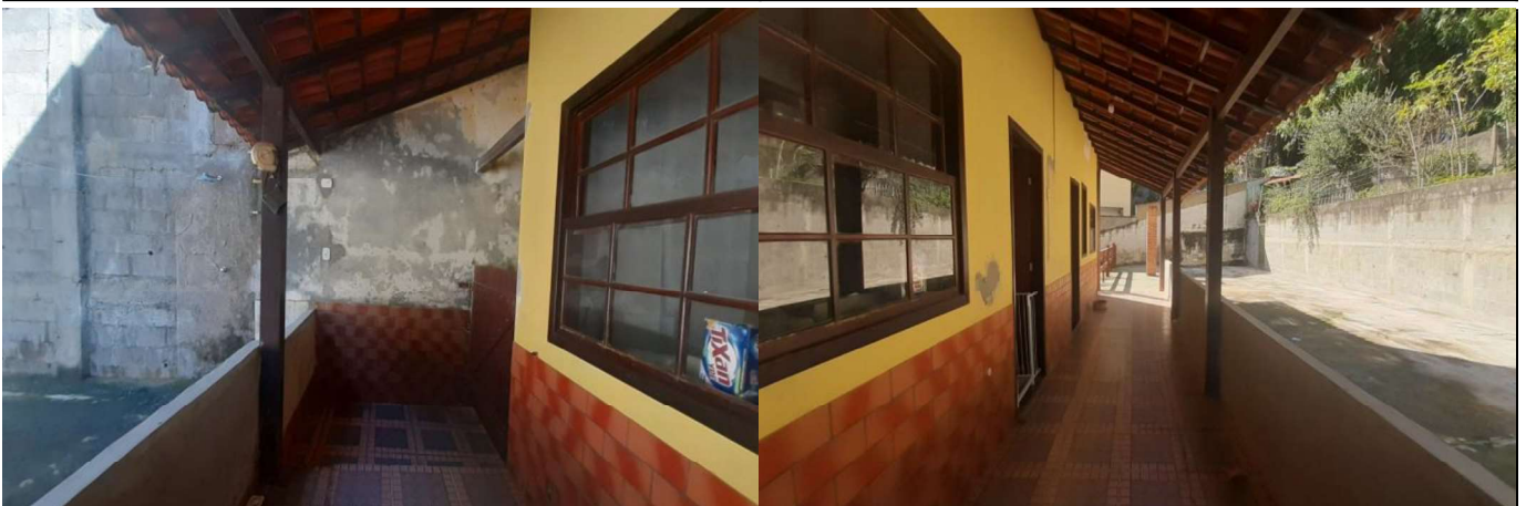
Varanda 2º pavimento
