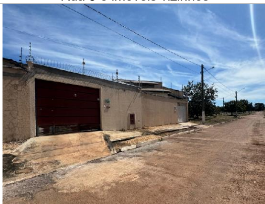
Fachada das casas 4 e 5
