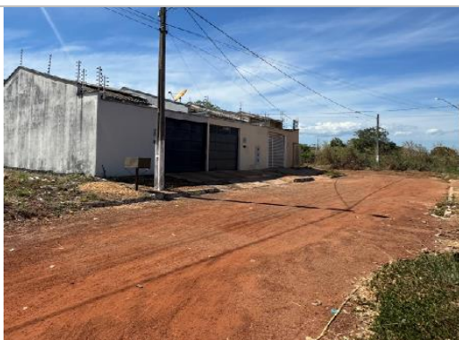
Vista geral da Rua 9 e fachada das casas 1 a 3
