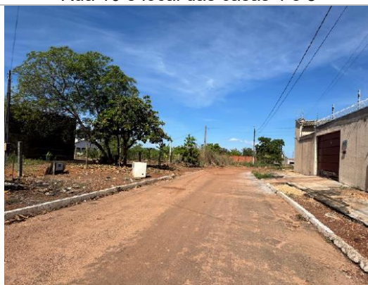
Vista geral da Rua 10
