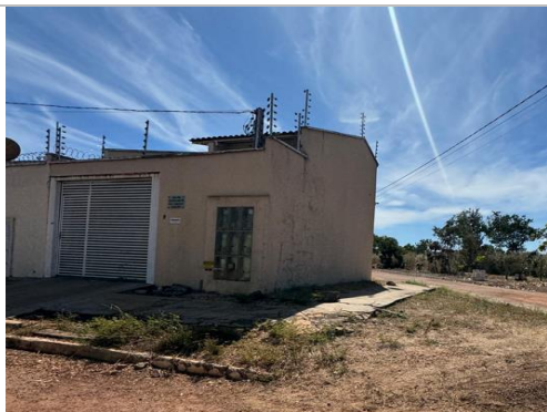
Fachada da casa 3, esquina com a Rua 10
