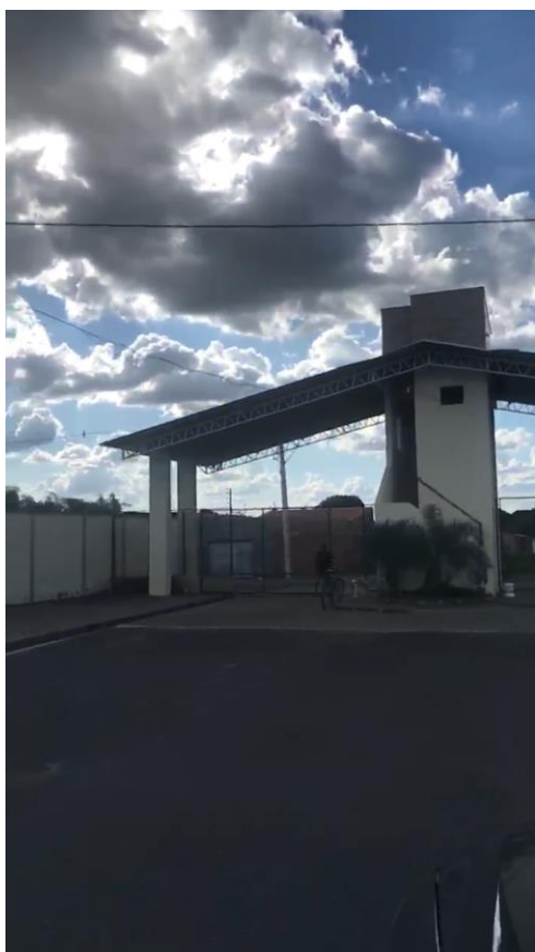
Portaria - vista interna
