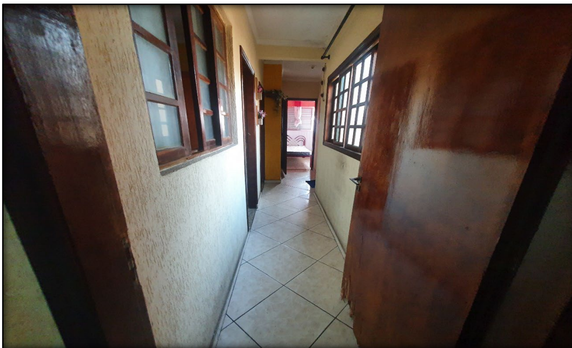
VISTA DO CORREDOR DO IMÓVEL.
