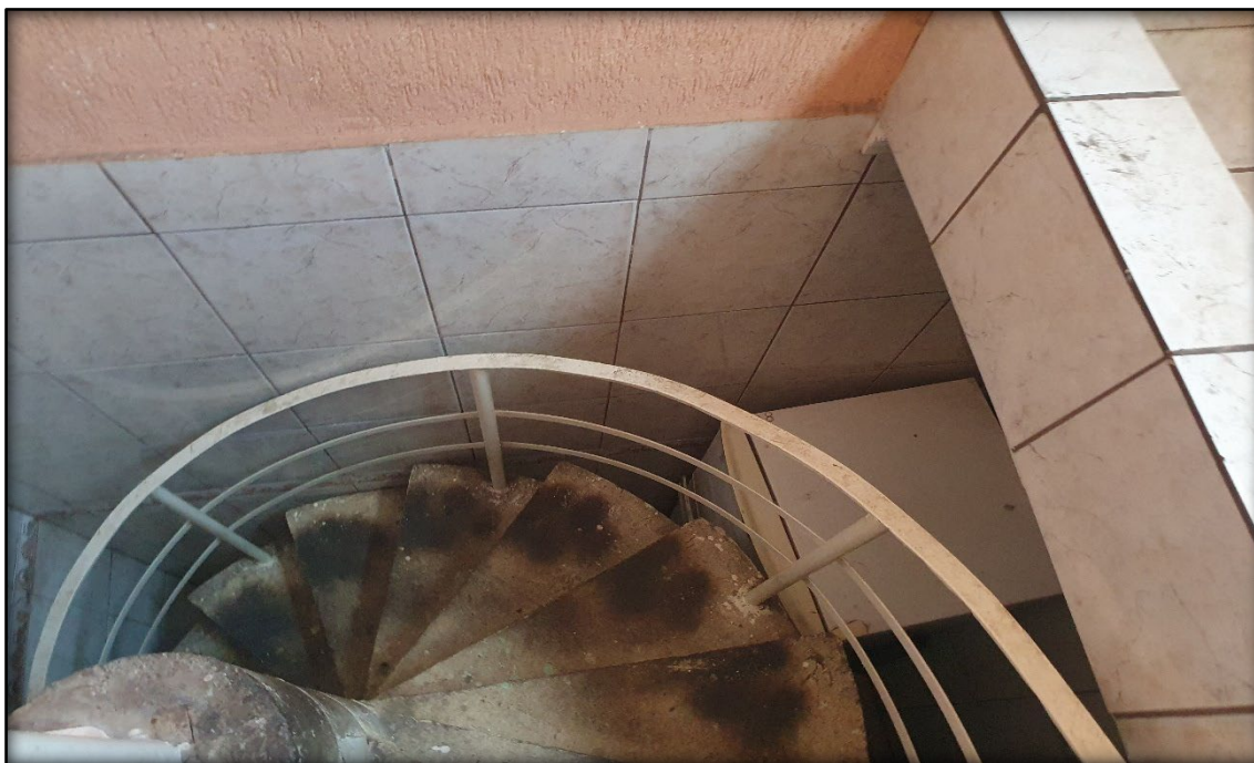
VISTA DA ESCADA ACESSO AO IMÓVEL.
