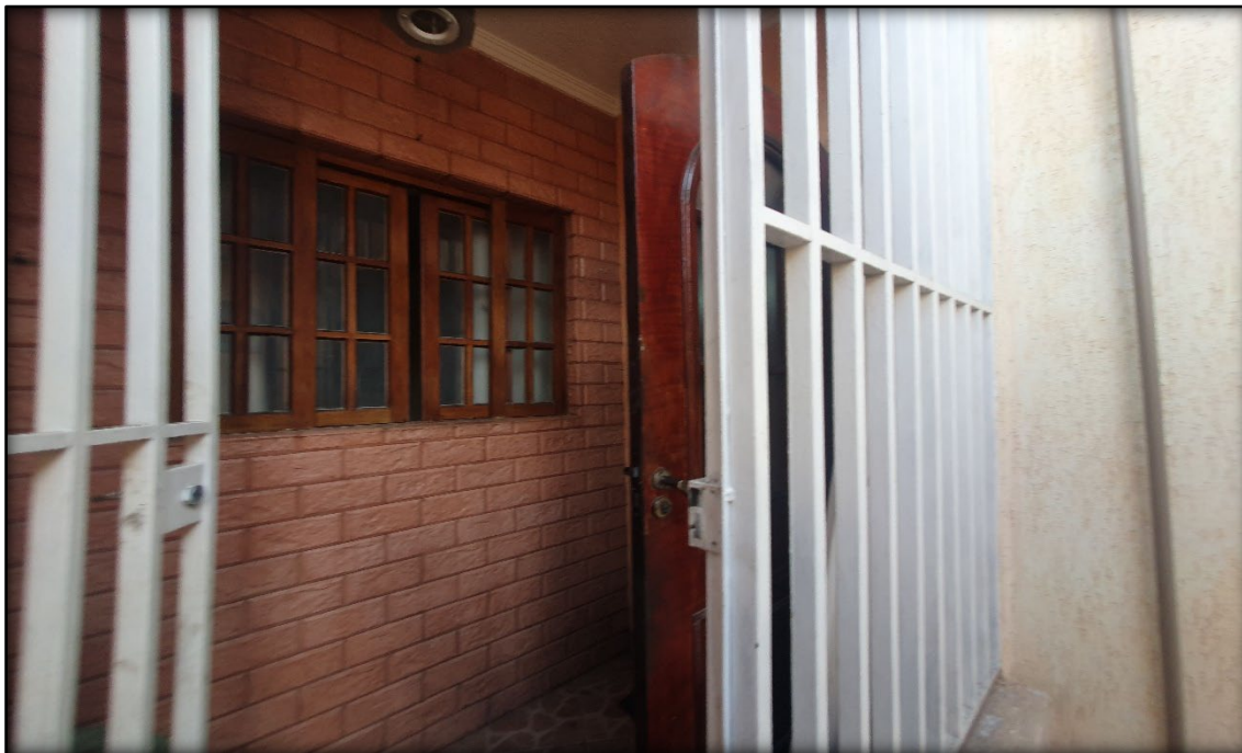
VISTA ENTRADA DO IMÓVEL
