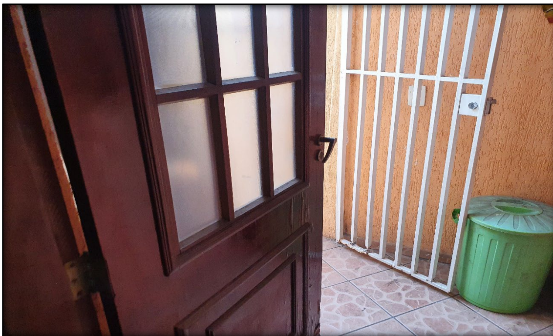
VISTA DO COMÔDO DO IMÓVEL.
