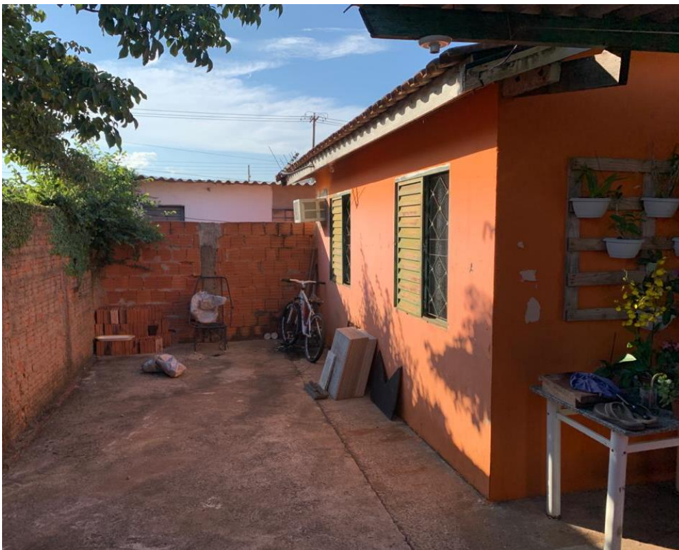
FOTO 4: Vista da lateral do imóvel:
