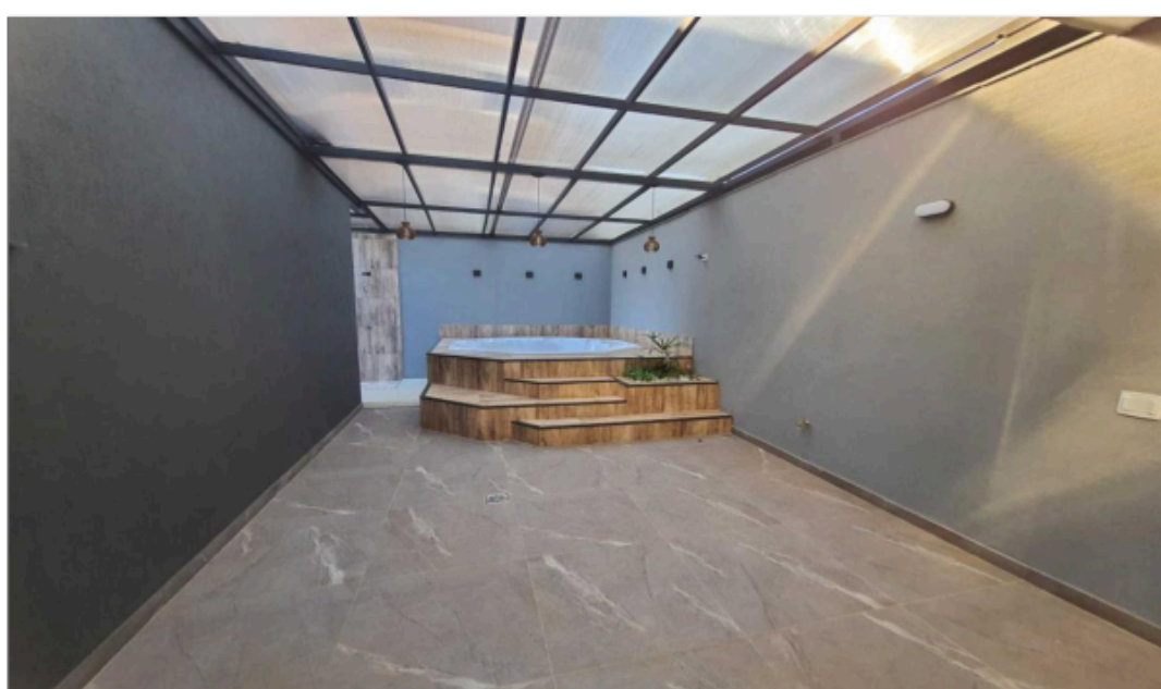
Descrição: VISTA PARCIAL INTERNA DO IMÓVEL
