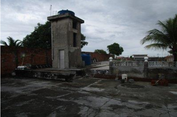
Caixa de água
