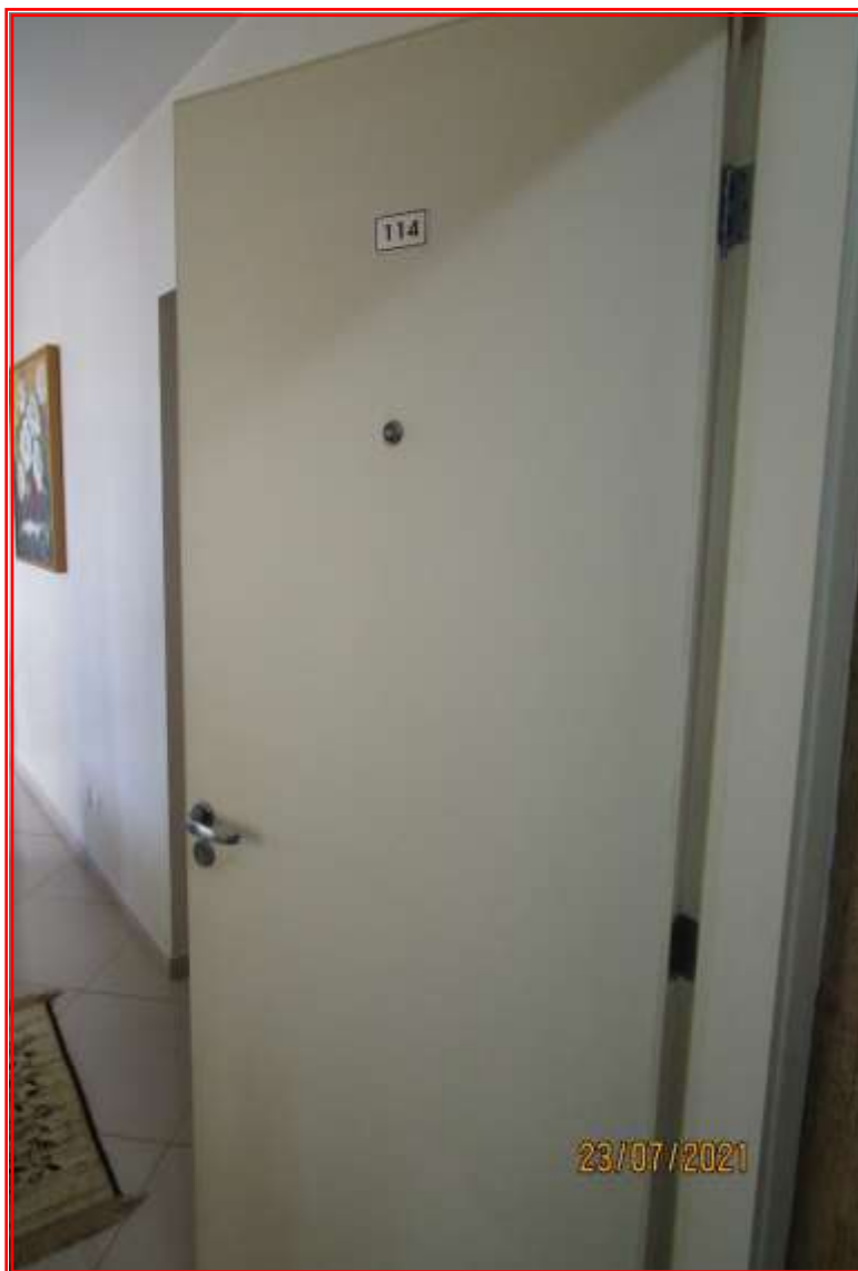
Foto nº 14: Vista da entrada do apartamento nº 114 (similar), objeto dos levantamento técnicos internos.
