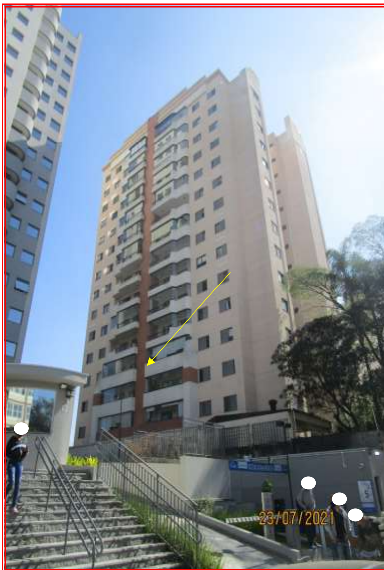
Foto nº 01: Vista geral do Helvetia Condominium, com detalhe para a fachada e vista panorâmica do imóvel avaliando voltado para a Avenida Itacira e Jabaquara.
