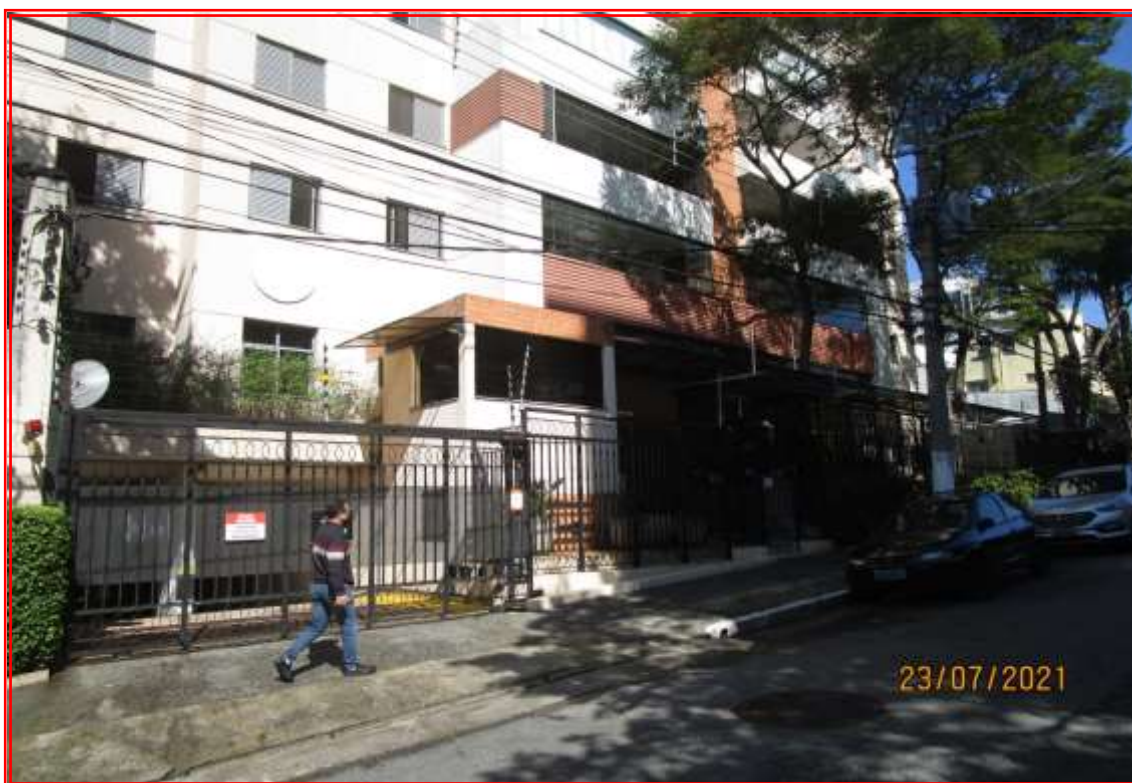
Foto nº 03: Vista geral do acesso a rampa da garagem e portaria central.
