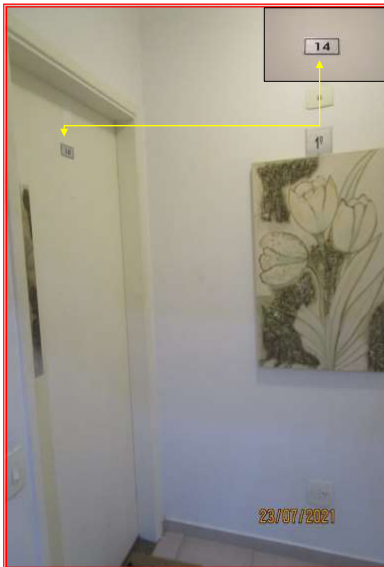
Foto nº 13: Vista geral do hall do 1º andar, com detalhe para a porta de acesso ao apartamento nº 14, objeto da avaliação. Na data da vistoria encontrava-se com seu morador ausente .
