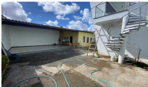
Descrição: VISTA PARCIAL DO IMÓVEL EM ESTUDO
