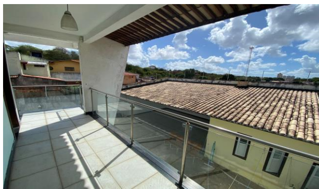
Descrição: VISTA PARCIAL DO IMÓVEL EM ESTUDO
