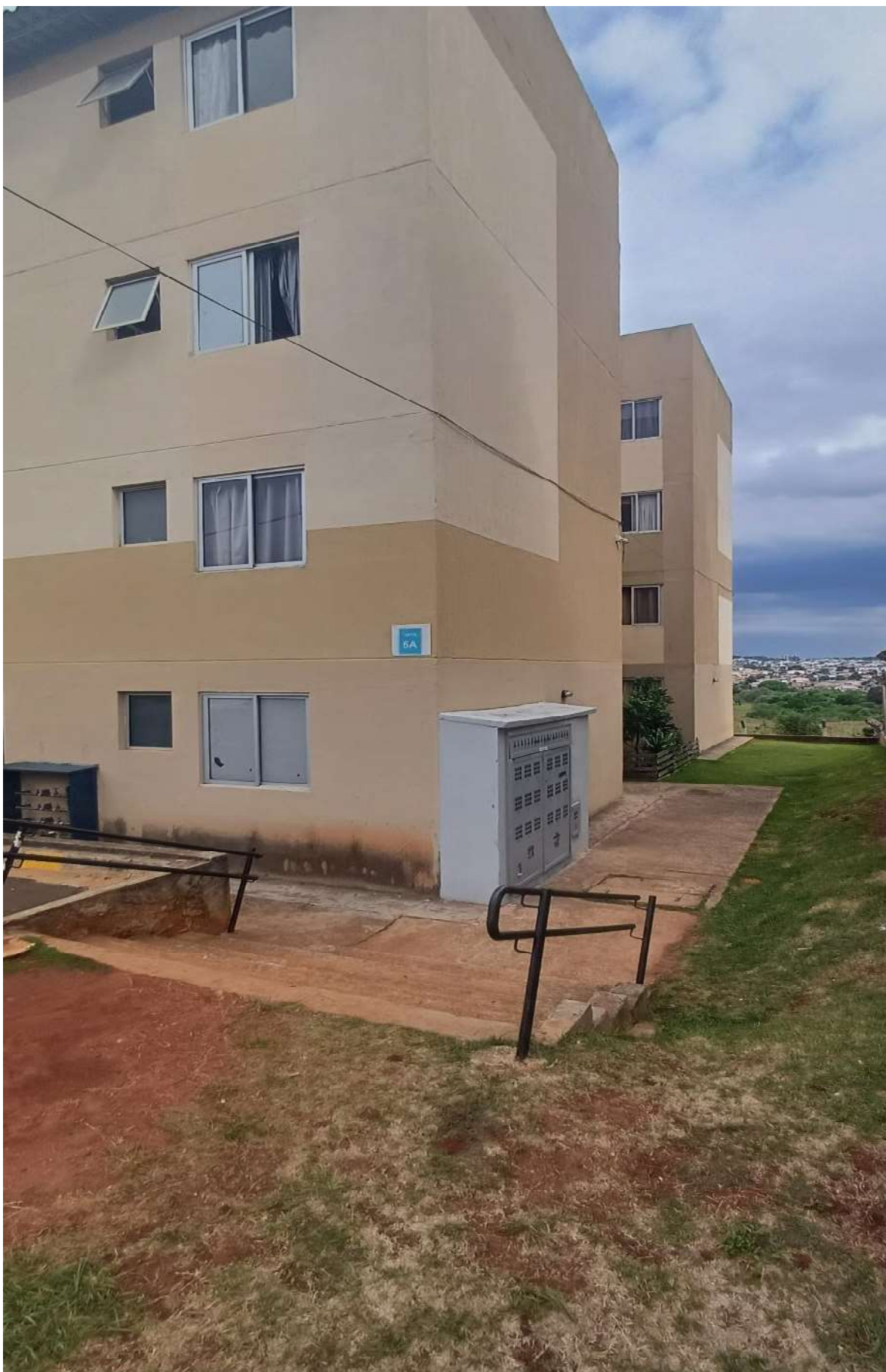
Legenda: Acesso ao Edifício.
