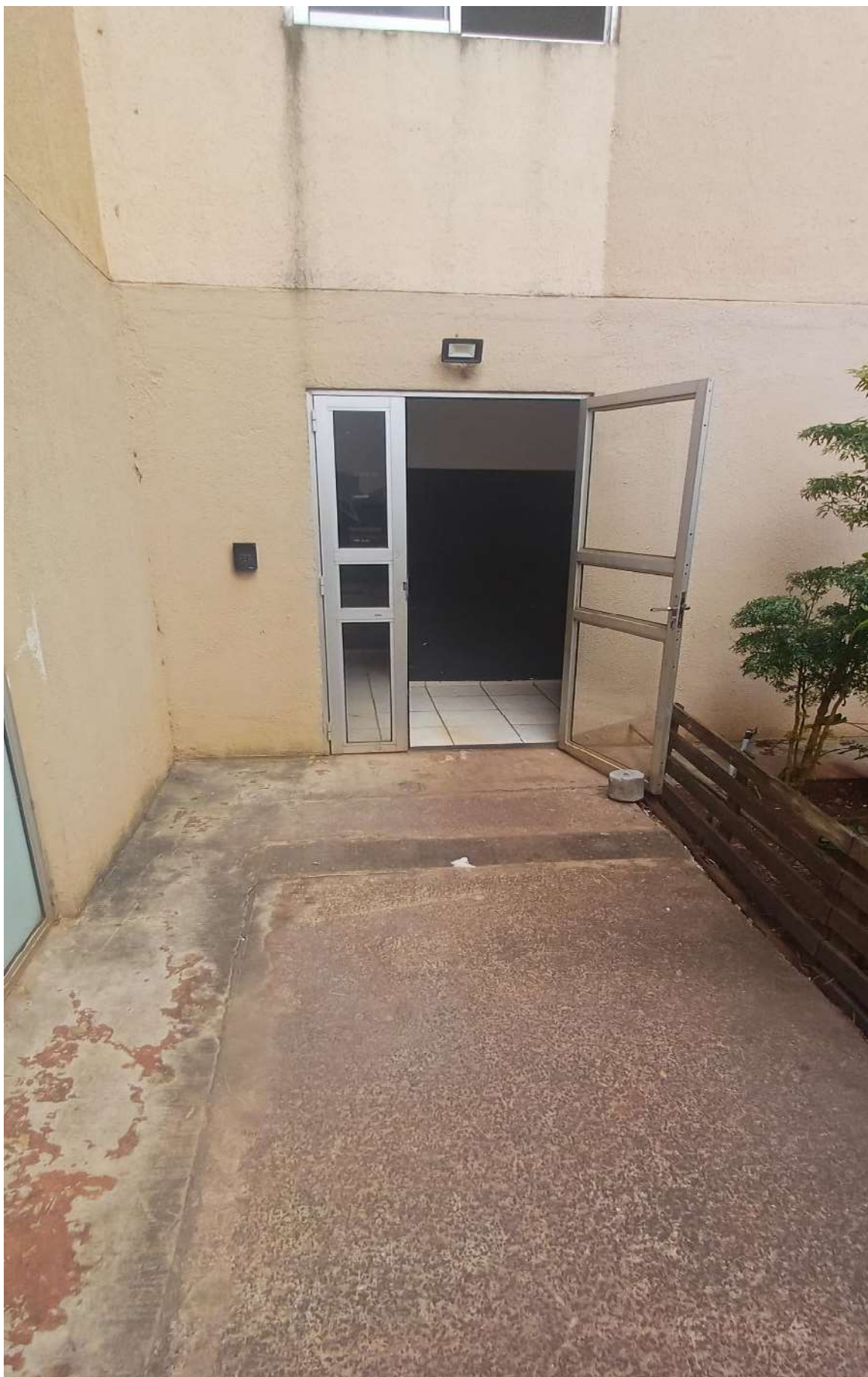
Legenda: Acesso ao Edifício.
