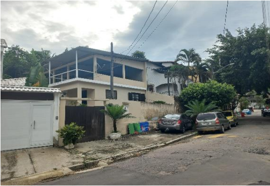
Fachada do avaliando
