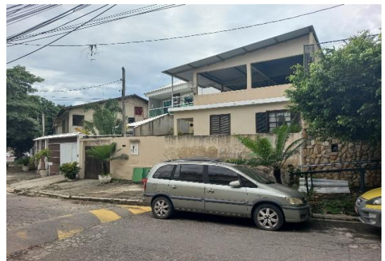
Fachada do avaliando
