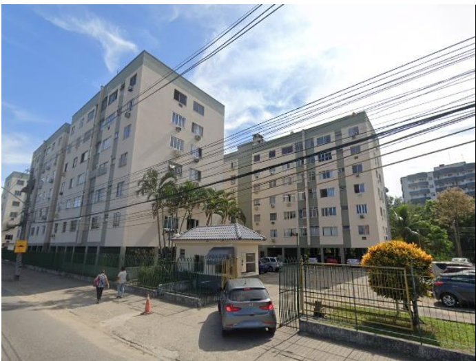
VISTA DA FACHADA DO IMÓVEL EM ESTUDO
