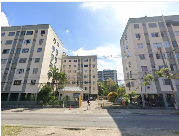
VISTA DA FACHADA DO IMÓVEL EM ESTUDO
