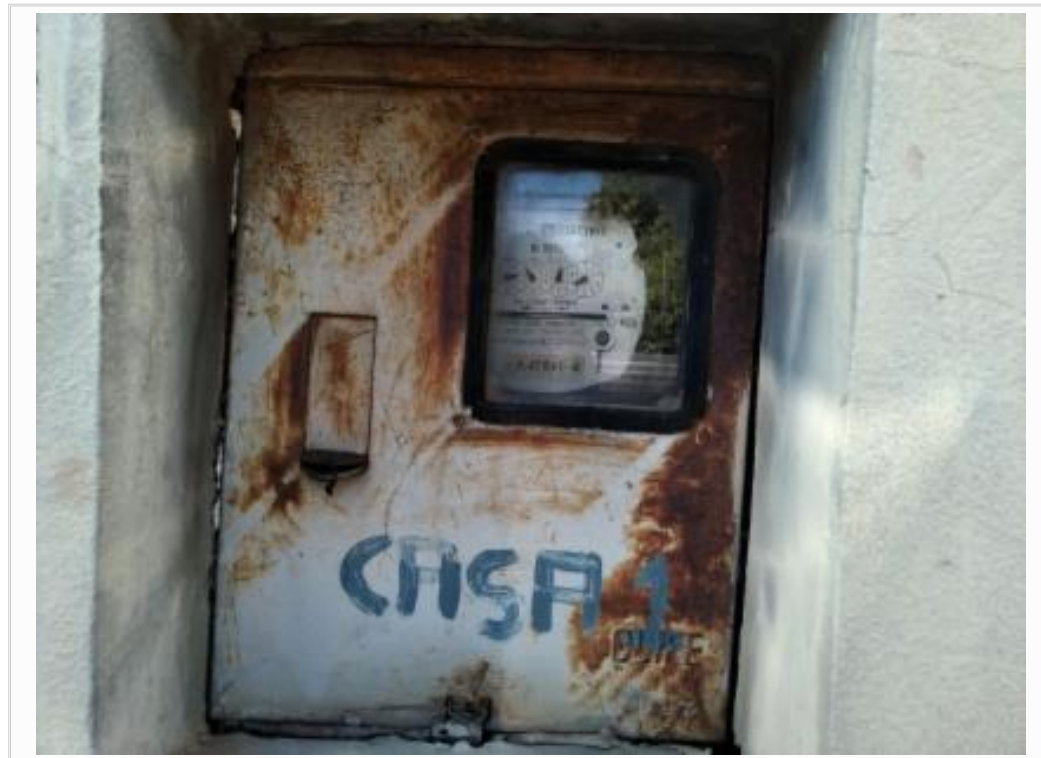
MEDIDOR DE ENERGIA
