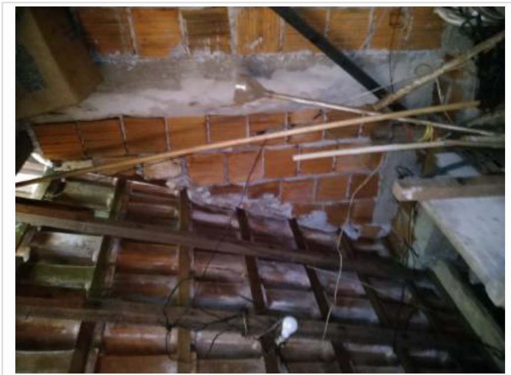
VISTA INTERNA DA OBRA
