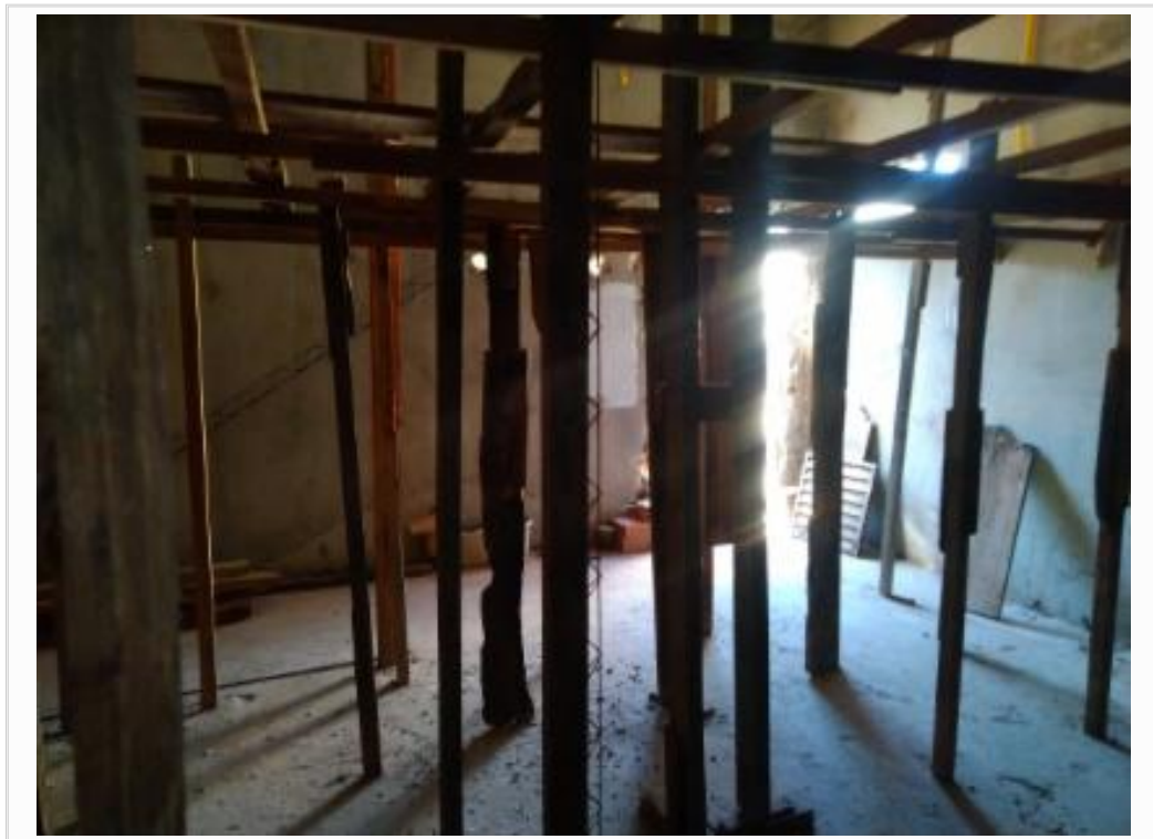
VISTA INTERNA DA OBRA
