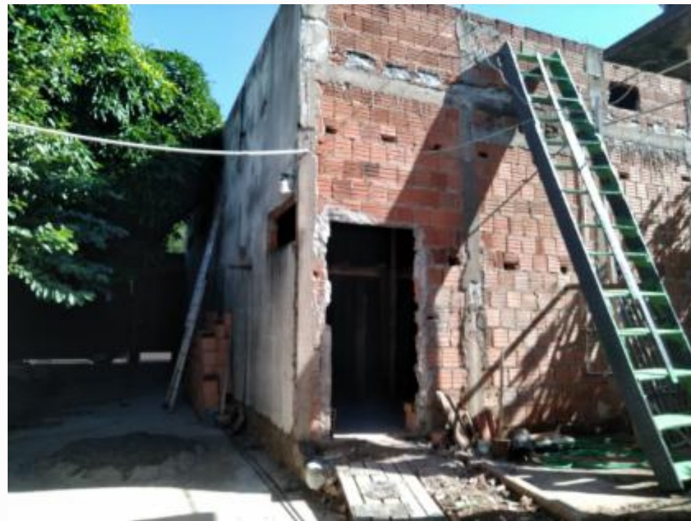
VISTA INTERNA DA OBRA
