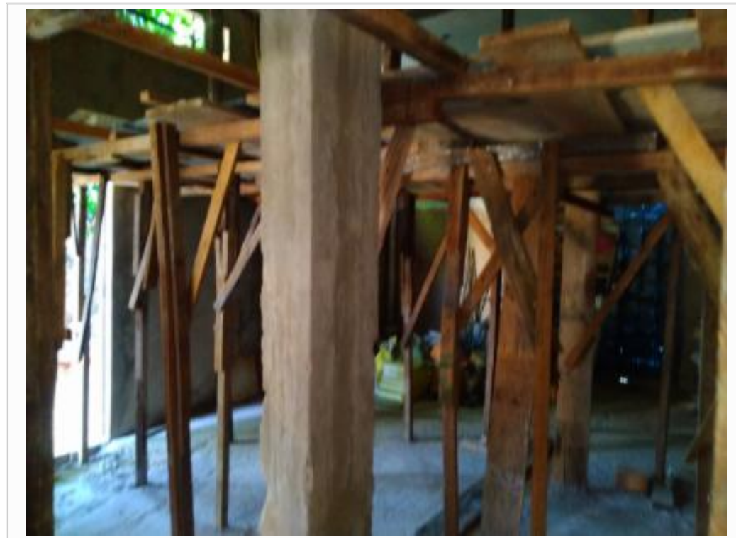
VISTA INTERNA DA OBRA
