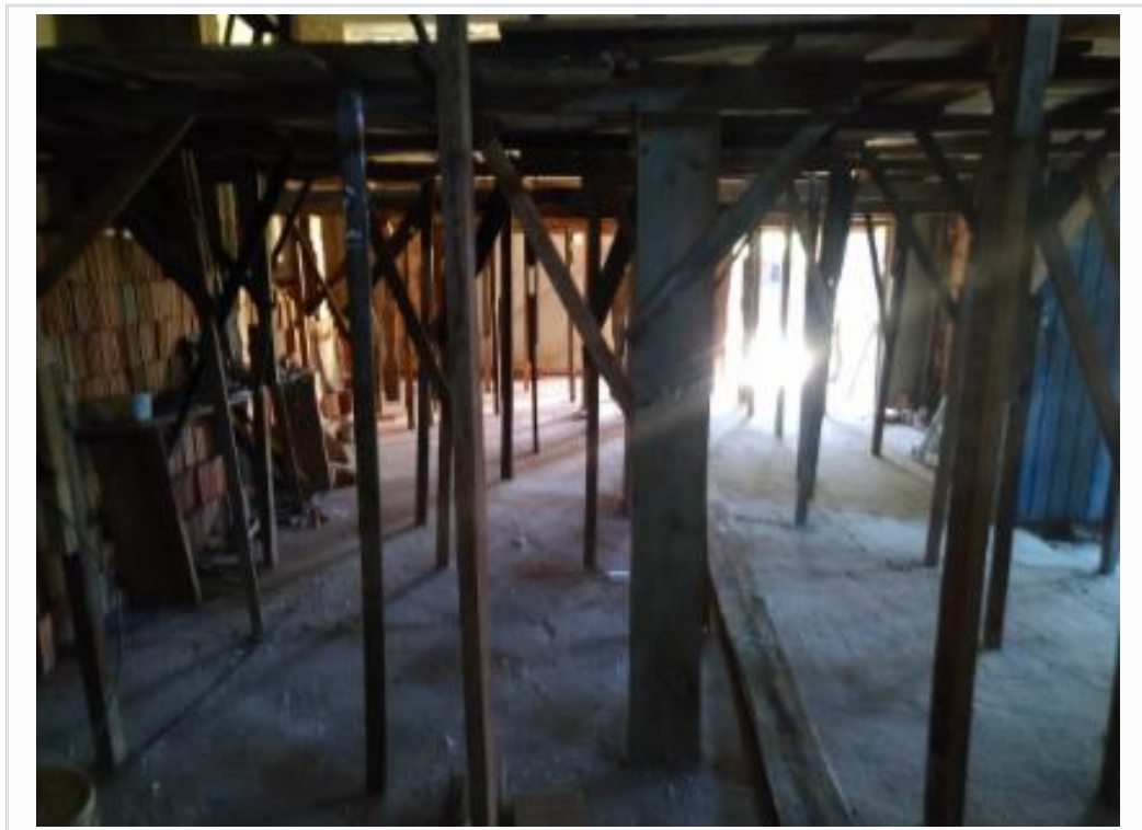
VISTA INTERNA DA OBRA
