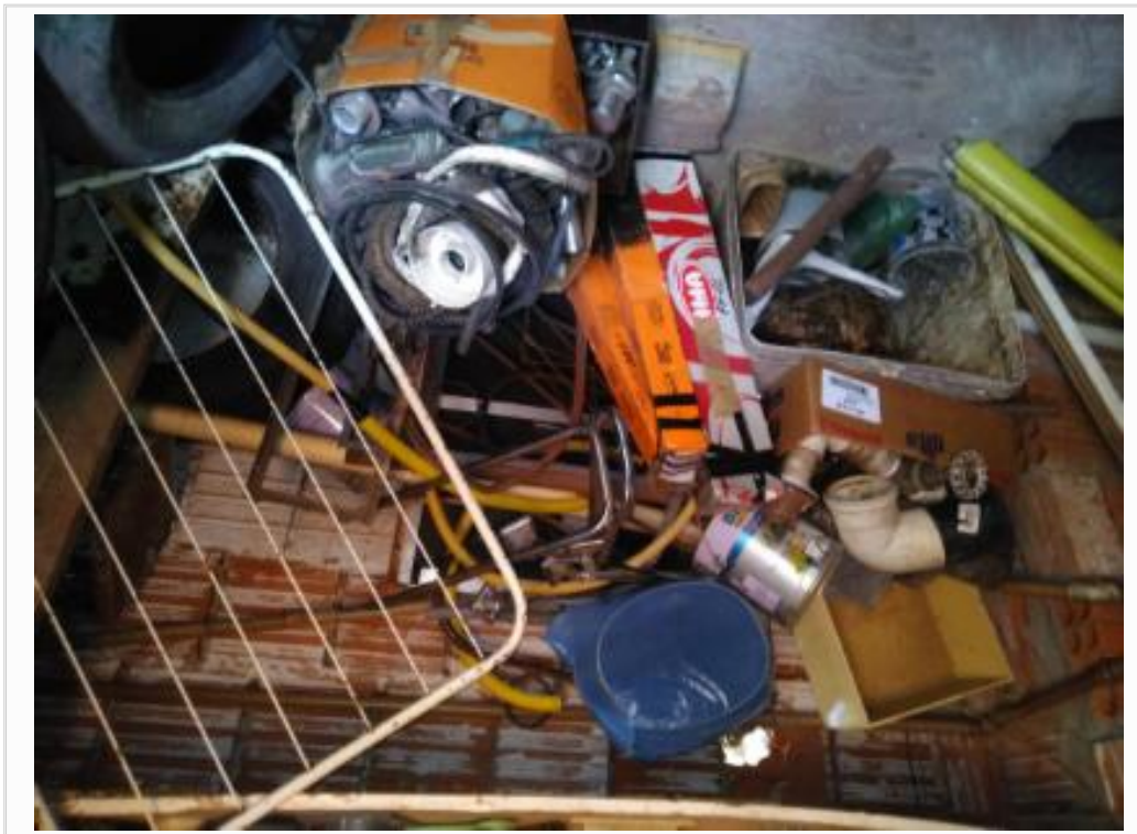
VISTA INTERNA DA OBRA
