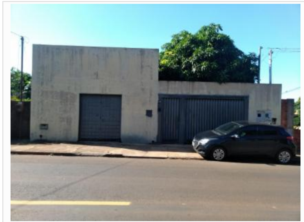
FACHADA DO AVALIANDO
