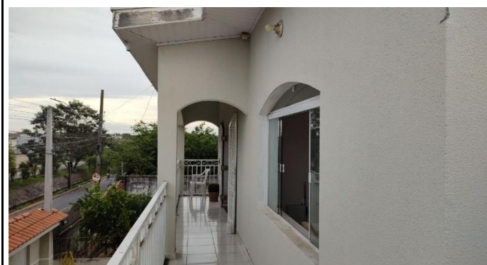
Varanda - Pavimento superior
