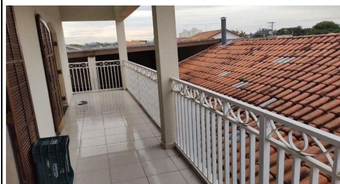
Varanda - Pavimento superior
