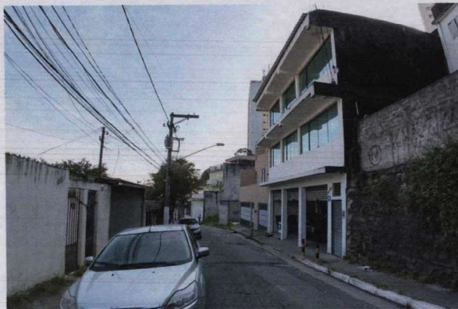
Foto 08 – Vista pela Rua São Romão, nº 110
