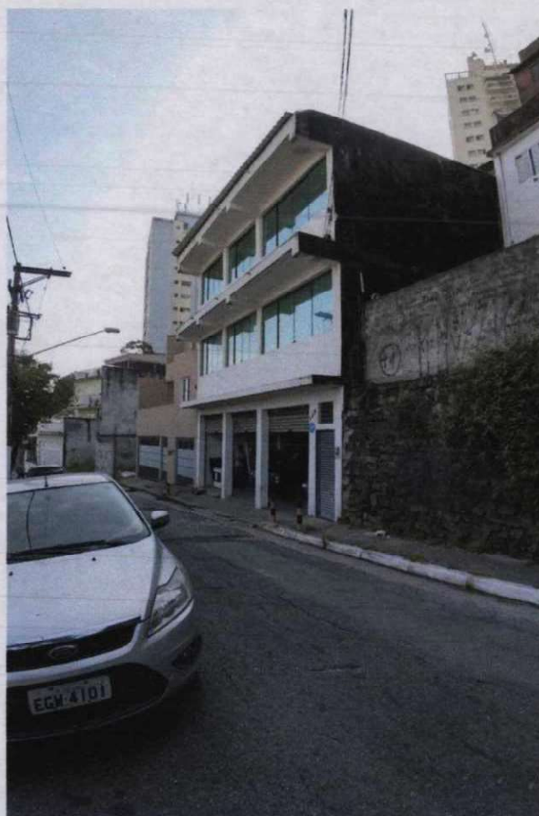
Foto 07 – Vista pela Rua São Romão, nº 110
