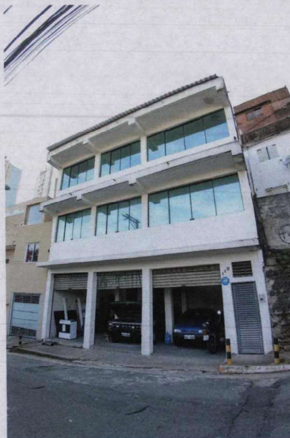
Foto 09 – Vista pela Rua São Romão, nº 110
