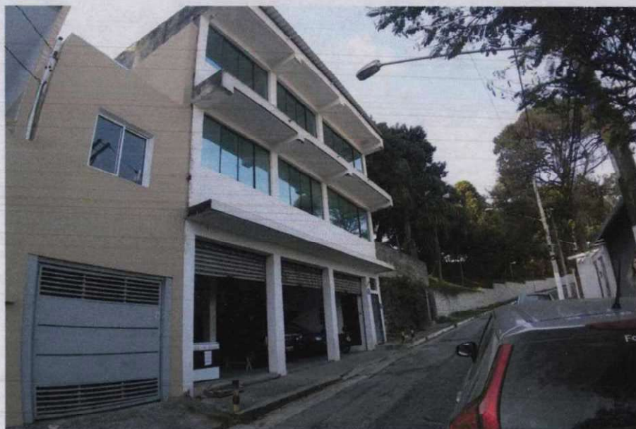
Foto 06 – Vista pela Rua São Romão, nº 110
