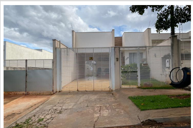
Vizinho à direita - Fachada
