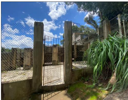
VISTA PARCIAL DO LOTE
