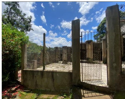
VISTA PARCIAL DO LOTE
