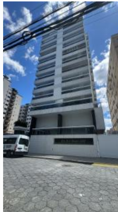
Fachada prédio avaliando
