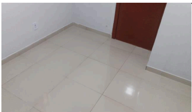
Descrição: VISTA PARCIAL INTERNA DO IMÓVEL
