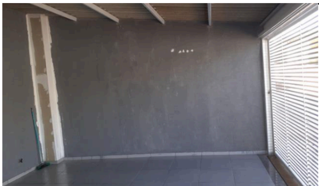
Descrição: VISTA PARCIAL INTERNA DO IMÓVEL
