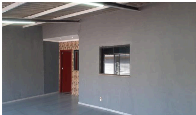
Descrição: VISTA PARCIAL INTERNA DO IMÓVEL
