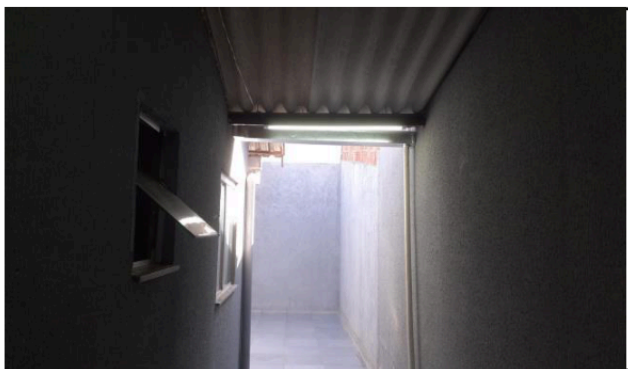
Descrição: VISTA PARCIAL INTERNA DO IMÓVEL
