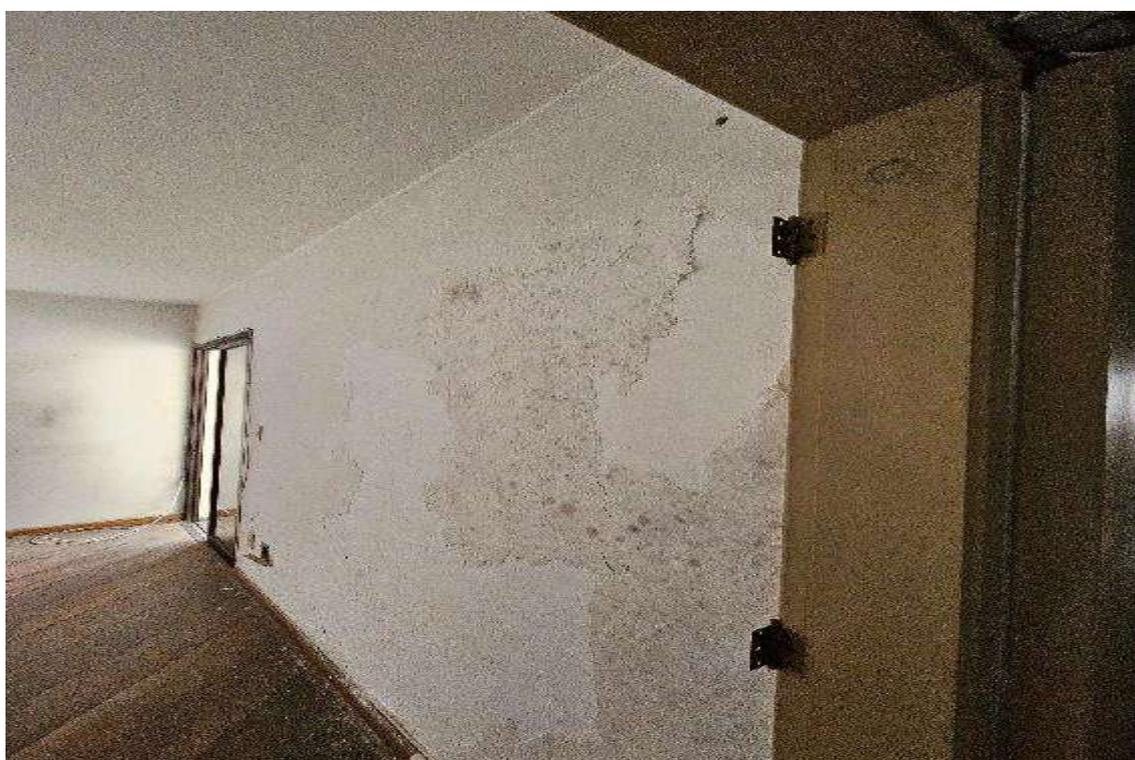
**FOTO 35** – Vista do dormitório II, com detalhe para a umidade na parede.
