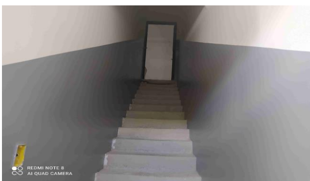
Descrição: VISTA PARCIAL INTERNA DO IMÓVEL
