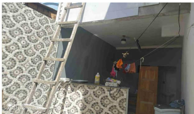
Descrição: VISTA PARCIAL INTERNA DO IMÓVEL
