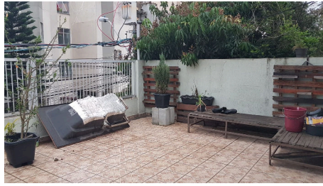
laje em cima da garagem
