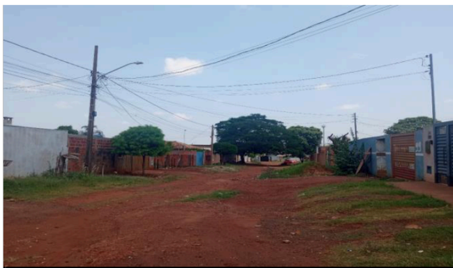
FOTO RUA VISÃO À ESQUERDA
