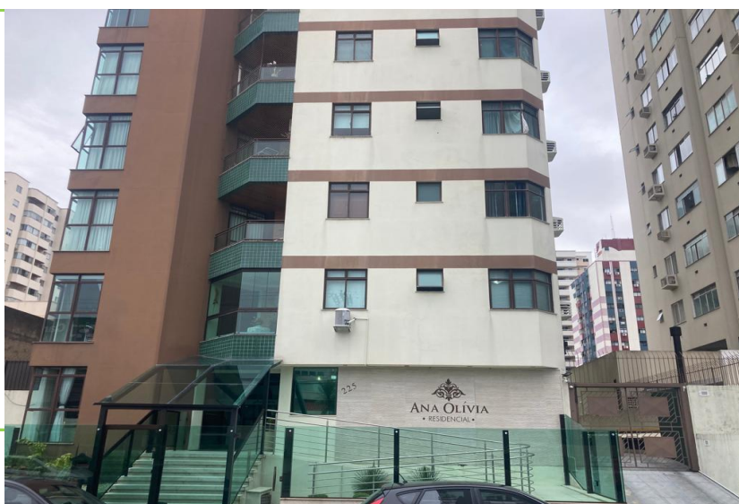
Foto da Fachada do Imóvel
