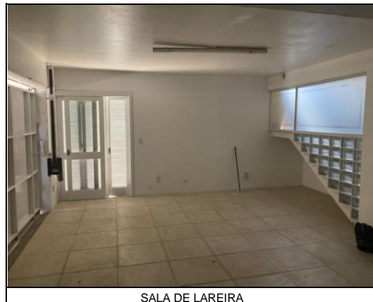
SALA DE LAREIRA
