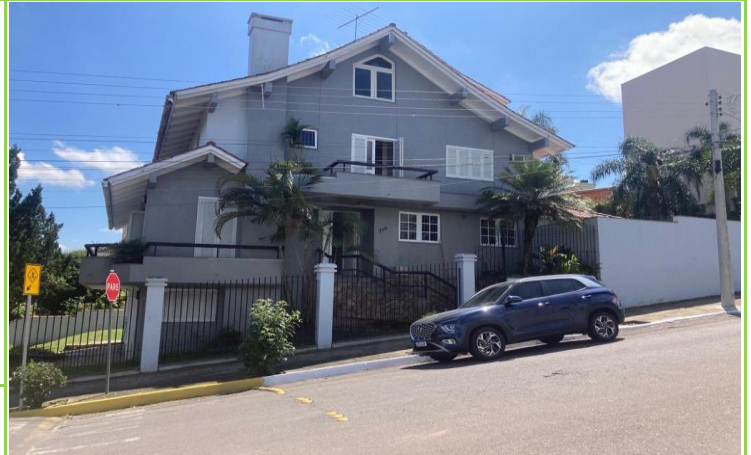
Foto da Fachada do Imóvel
