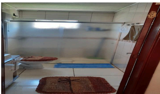
Descrição: BANHEIRO SOCIAL
