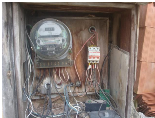
MEDIDOR DE ENERGIA
