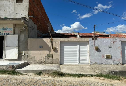
Fachada do avaliando
