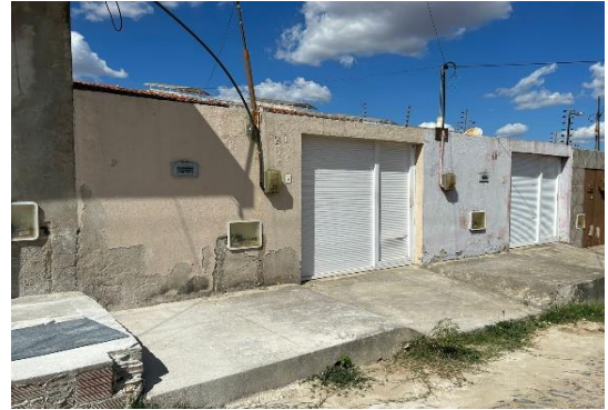
Fachada do avaliando
