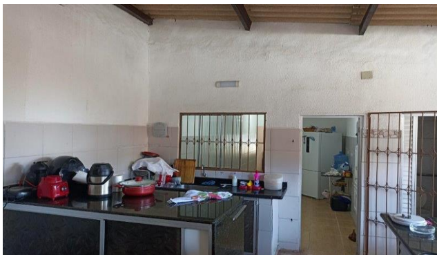
Descrição: VISTA PARCIAL INTERNA DO IMÓVEL
