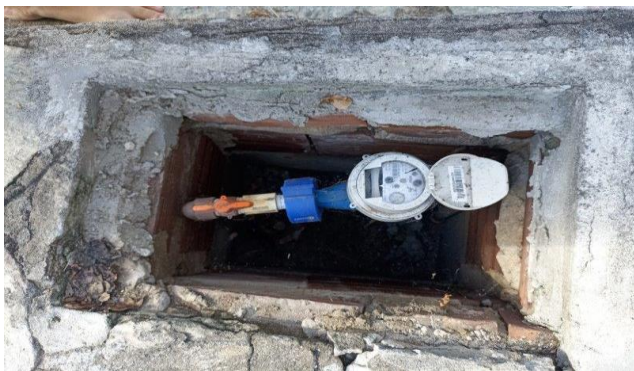
Descrição: VISTA PARCIAL INTERNA DO IMÓVEL
