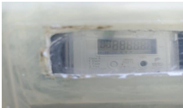
Descrição: VISTA PARCIAL INTERNA DO IMÓVEL
