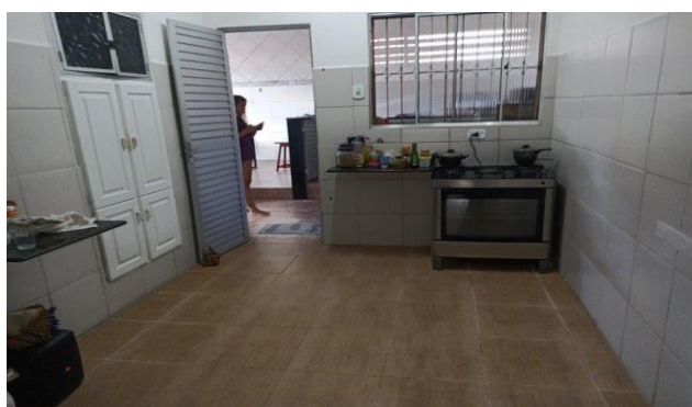
Descrição: VISTA PARCIAL INTERNA DO IMÓVEL
