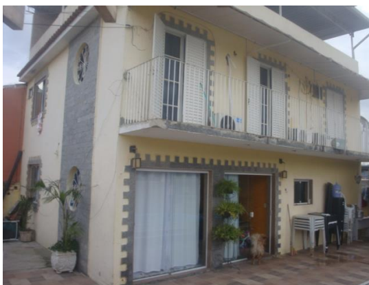
VISTA INTERNA DO IMÓVEL
