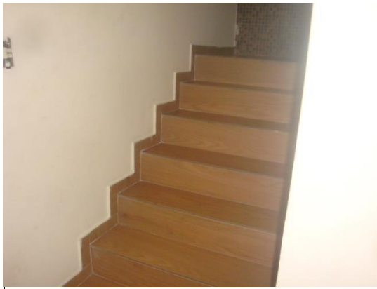
ACESSO ENTRE OS PAVIMENTOS
