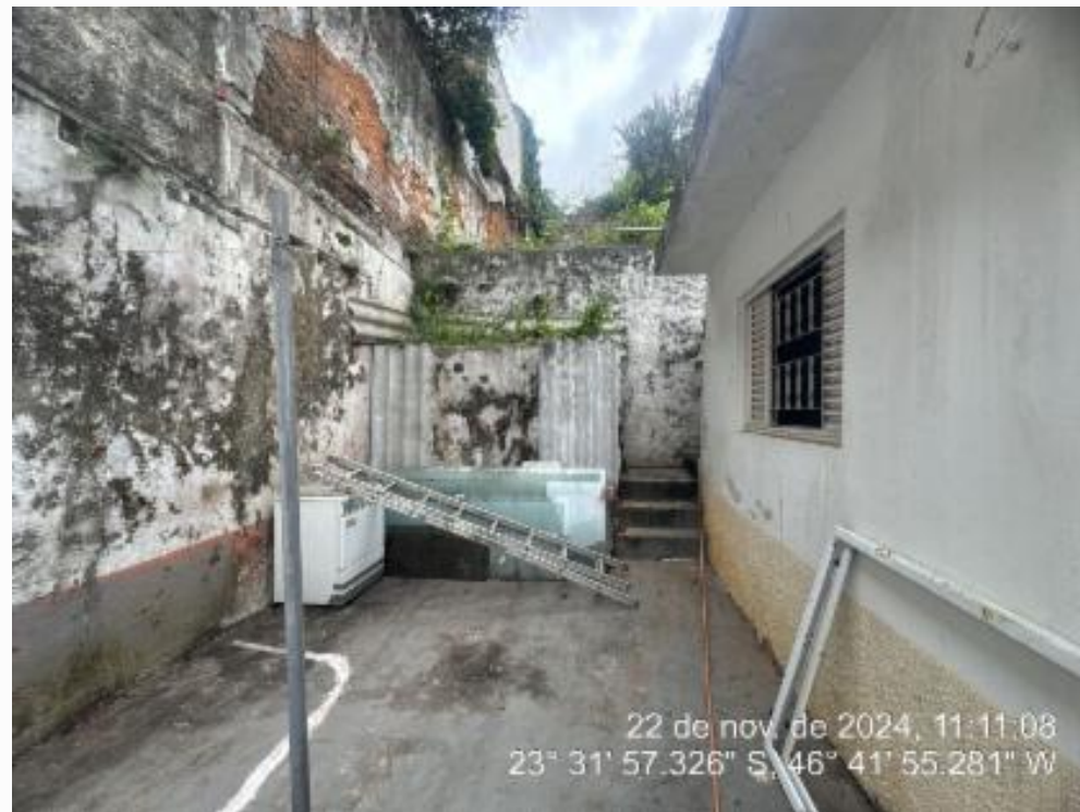
asa 02- Acesso ao pavimento 03
