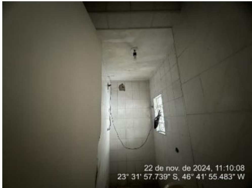
Casa 02- Banheiro social.
