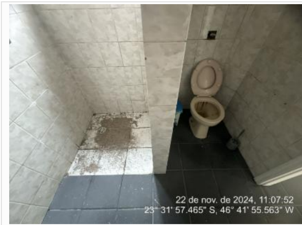
Casa 01- Banheiro social
