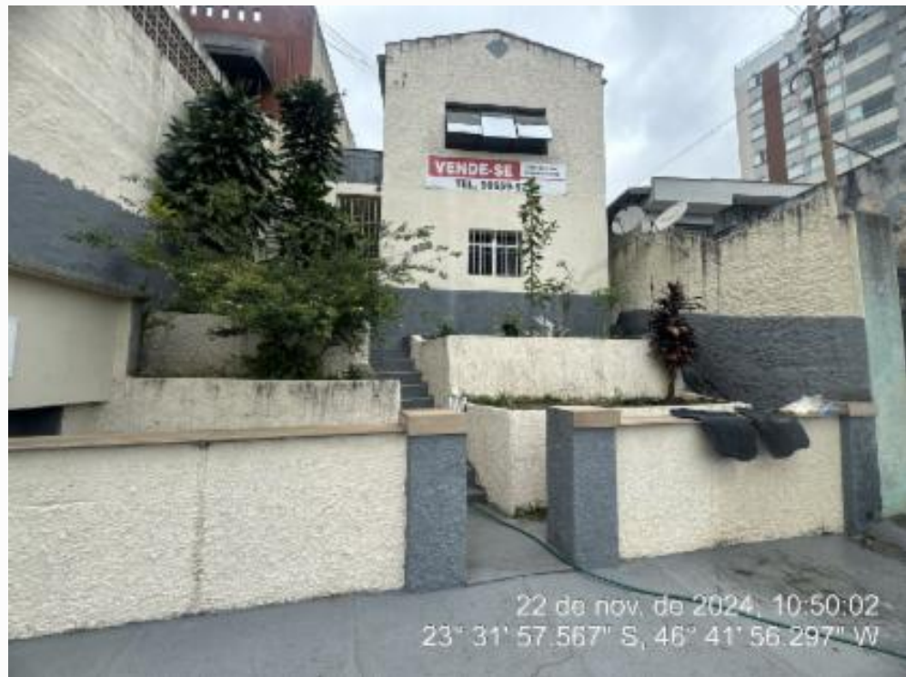
Fachada do avaliando
