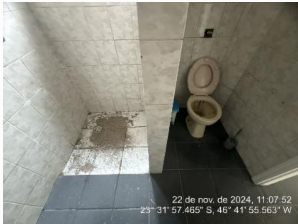
Casa 01- Banheiro social
