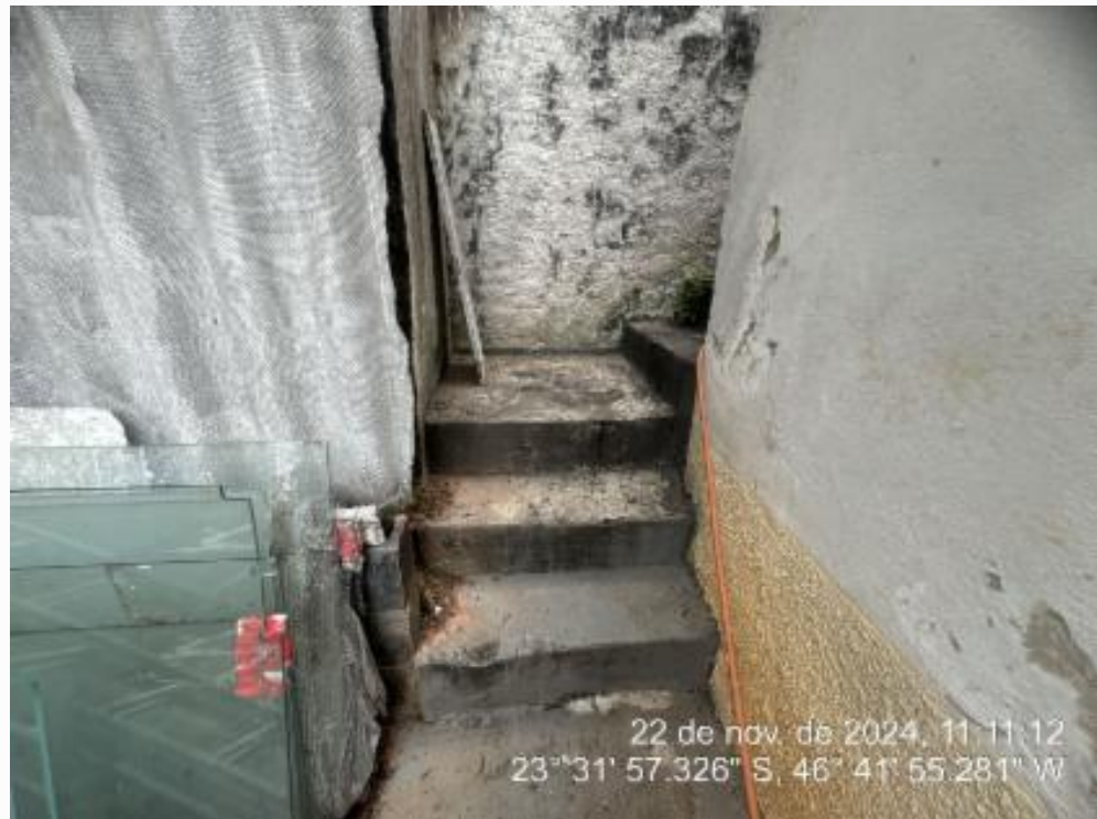
Acesso ao 3º pavimento
