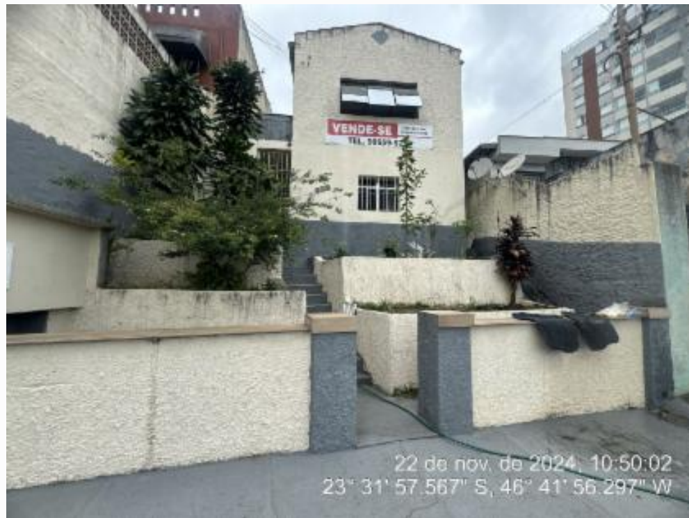
Fachada do avaliando
