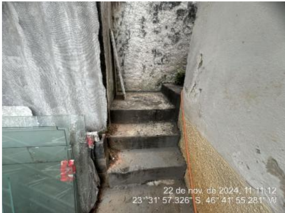
Acesso ao 3º pavimento
