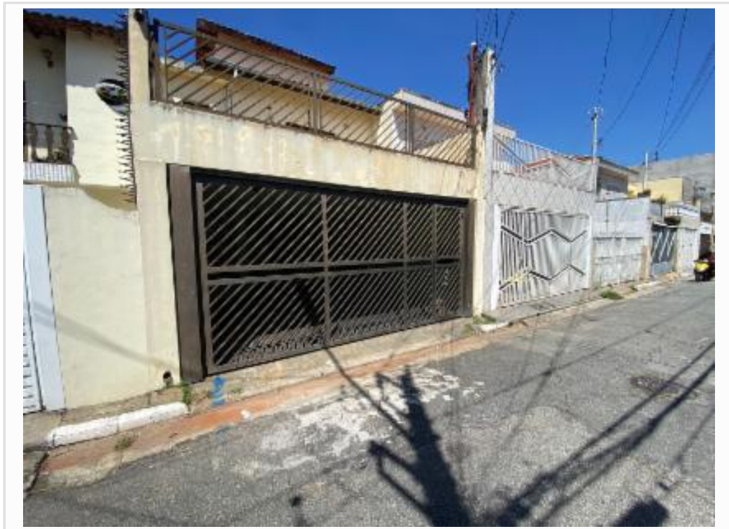
Fachada do imóvel - vista 2
