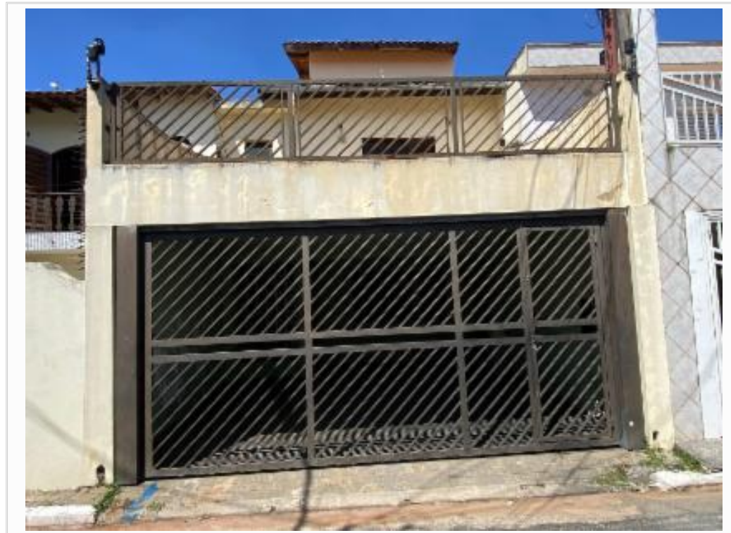
Fachada do imóvel - vista 1
