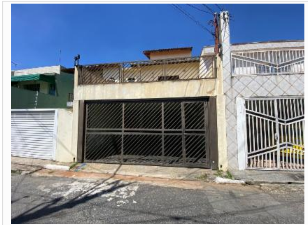
Fachada do imóvel - vista 3
