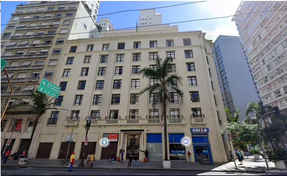
Foto da Fachada do Imóvel
