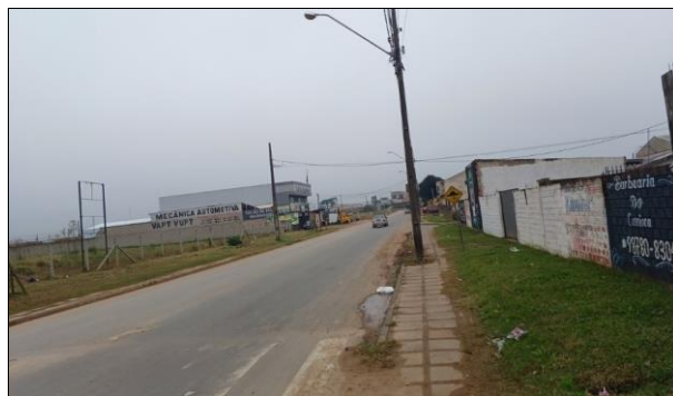
Descrição: Logradouro externo
