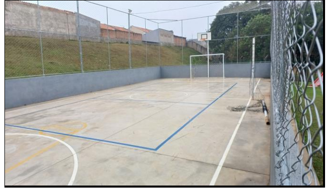
Descrição: QUADRA POLIESPORTIVA
