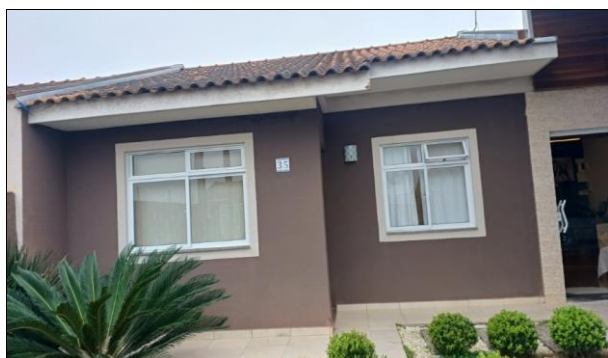
Descrição: Frente do imóvel / Identificação numérica
