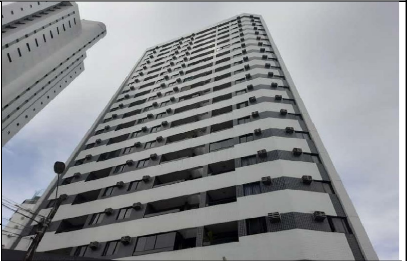
Foto da Fachada do Imóvel
