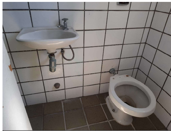
VISTA PARCIAL INTERNA DO BANHEIRO DE SERVIÇO
