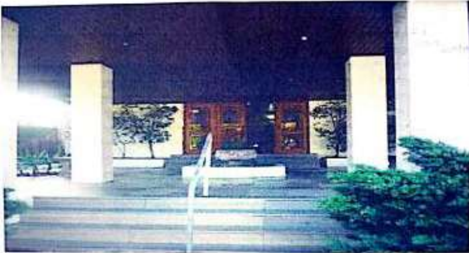
Área de entrada do Edifício Monte Carlo.
