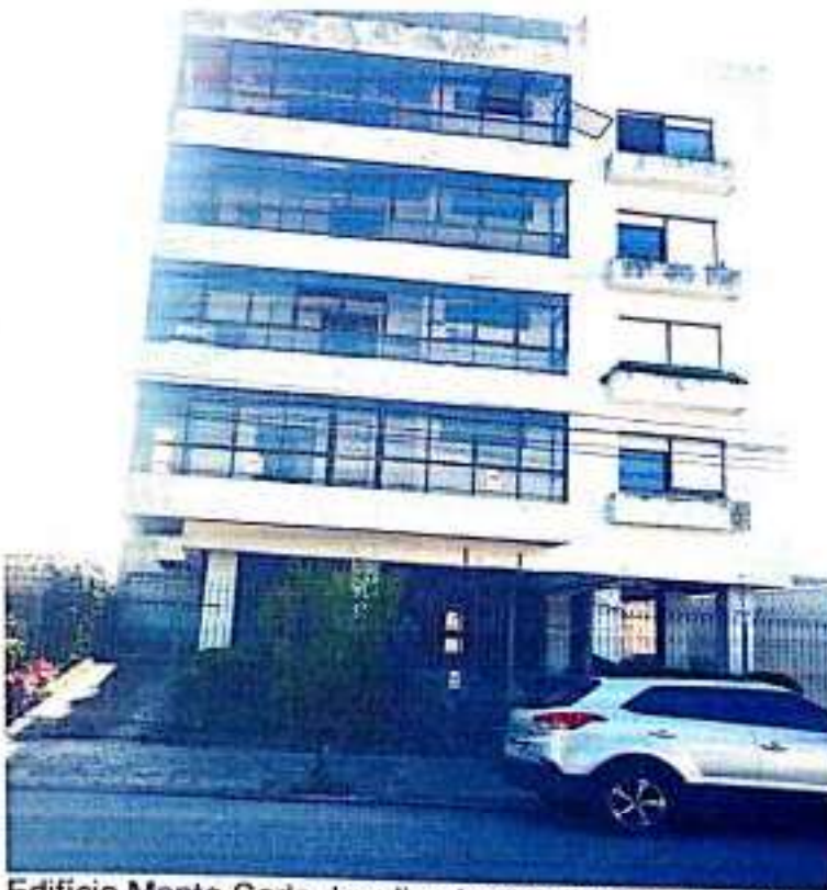
Edifício Monte Carlo, localizado de frente para a Rua: General Osório, 1223
