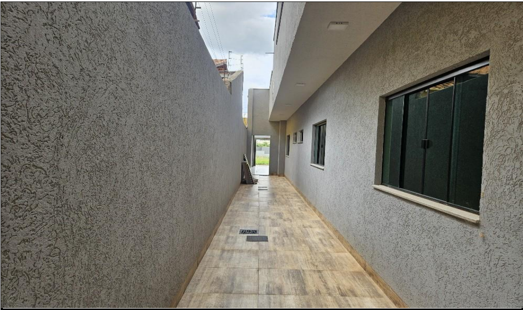
Descrição: VISTA DO IMÓVEL
