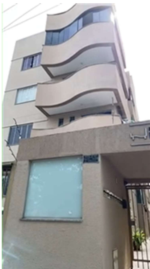
Fachada do Prédio
