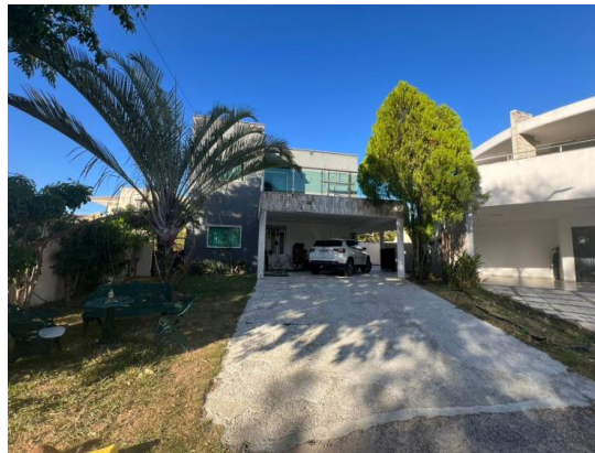
VISTA DA FACHADA DO IMÓVEL EM ESTUDO
