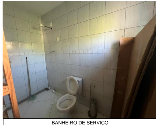
BANHEIRO DE SERVIÇO
