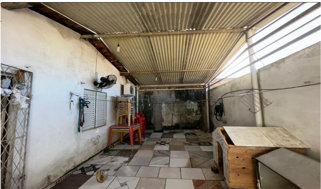
Descrição: VISTA PARCIAL INTERNA DO IMÓVEL
