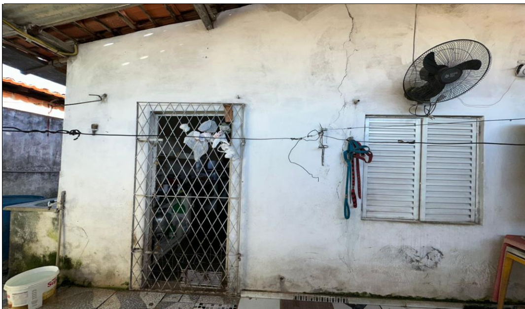
Descrição: VISTA PARCIAL INTERNA DO IMÓVEL
