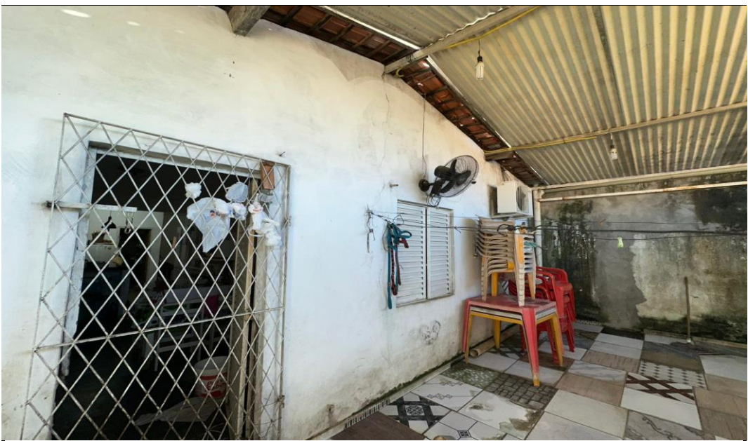
Descrição: VISTA PARCIAL INTERNA DO IMÓVEL
