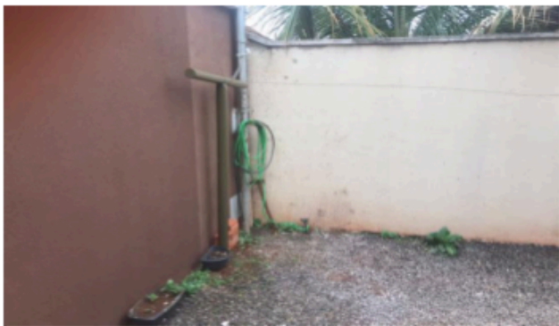
Descrição: VISTA PARCIAL INTERNA DO IMÓVEL
