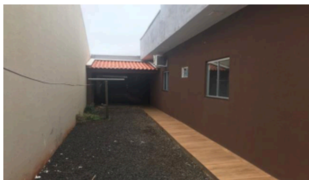
Descrição: VISTA PARCIAL INTERNA DO IMÓVEL
