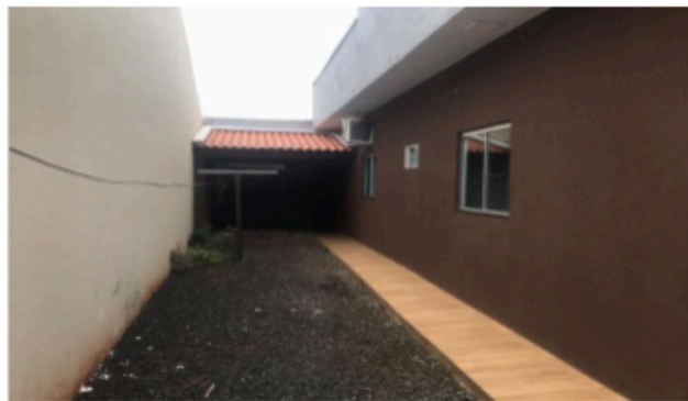
Descrição: VISTA PARCIAL INTERNA DO IMÓVEL
