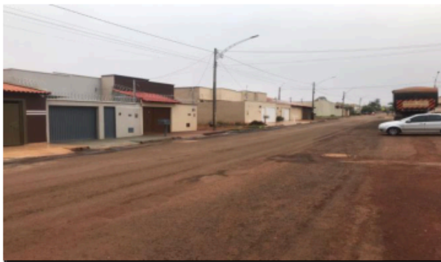
FOTO RUA VISÃO À ESQUERDA
